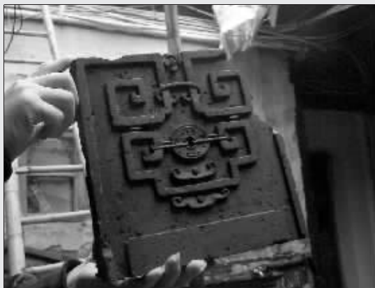
坍塌处掉下的一块古砖
