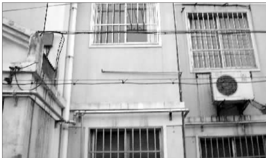
图中钢窗就是天然气管道
