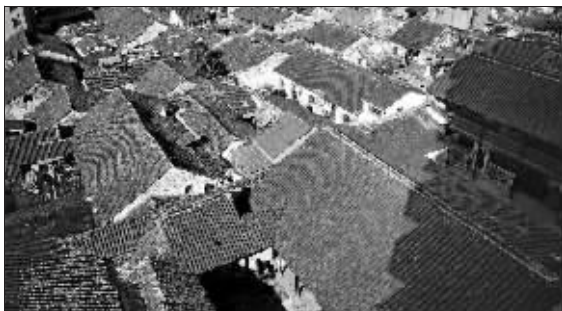
[ 拆迁前 ] 修缮工程动工前,前后北岸整片的古建筑
