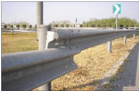
螺栓被偷,护栏套拉下来
