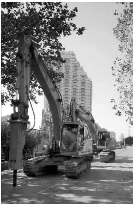
大型挖掘机已开进辅桥施工 快报记者 田雪亭摄
