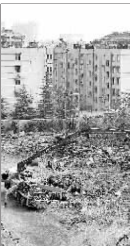
江苏省第二中医院新建大楼工地。快报记者 施向辉 摄
