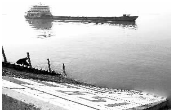
10月27日,一艘货轮从三峡船闸上游引航道的水位标尺旁驶过。新华社记者 郝同前 摄
