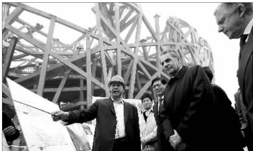
10月24日,国际奥委会主席罗格(右二)在“鸟巢”工地听取施工进度情况介绍。当日,国际奥委会主席罗格在北京市委书记、北京奥组委主席刘淇的陪同下参观了国家体育场“鸟巢”和国家游泳中心“水立方”的施工现场。新华社记者 孟永民 摄
