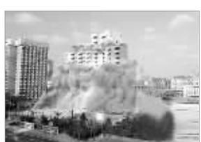
“轰……”10月15日下午3时56分,随着一声巨响,位于青岛山东路15号总高度62米、19层高的青岛大酒店,在3秒钟内全部倒塌。由青岛市第一市政公司实施的这次定向爆破,因建筑物的高度、全混凝土结构形式和周边环境复杂等困难条件,被爆破业专家称为“全国第一爆”。 据《青岛早报》
