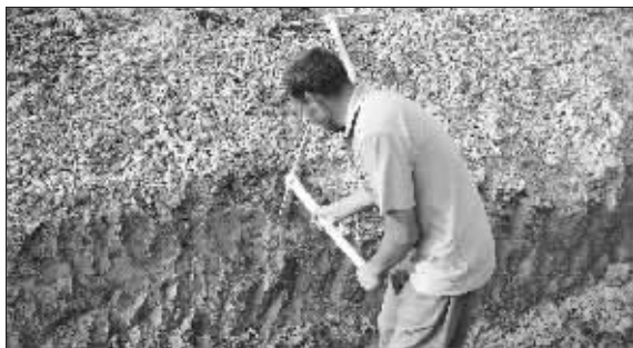
工人正在工地施工 快报记者 薛林 摄
