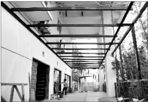
烧烤店已经在通道顶上搭好钢架了 快报记者 施向辉 摄
