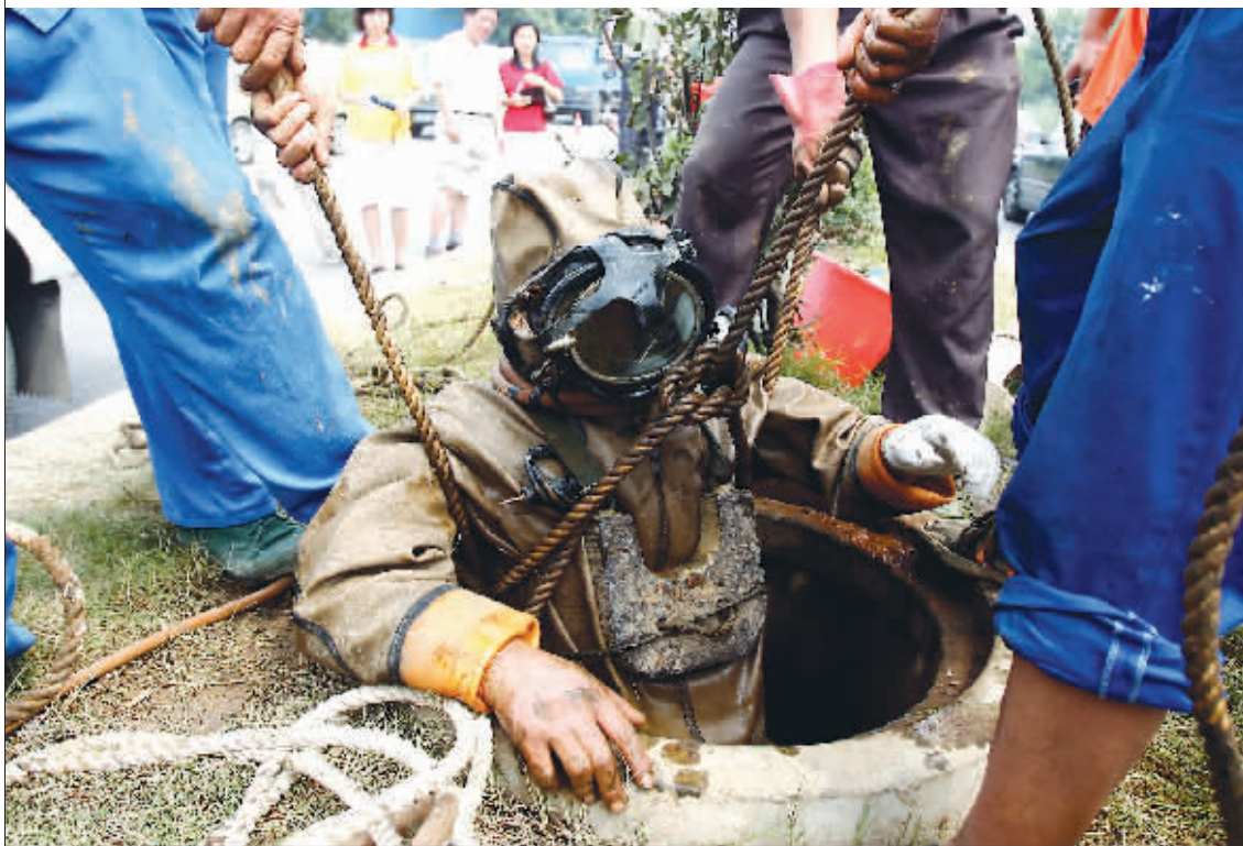
快报《滚滚污水为外秦淮补“脏血”》的报道引起南京市委、市政府高度重视。南京钛白化工有限公司前晚起全面停产整改。昨天,潜水员钻进4米多深的下水道,打通了“堵头”,这样,该公司产生的污水将被输进市政管网,运往污水处理厂处理。 快报记者 顾炜 摄
