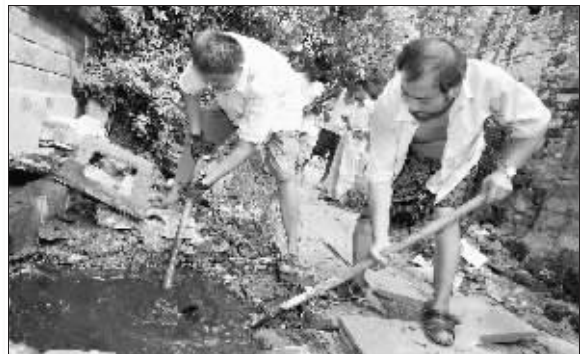
昨天,工人们在疏通管道 快报记者 施向辉 摄
