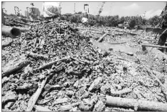
从静海寺遗址上挖出的大量木屑堆积在地上
