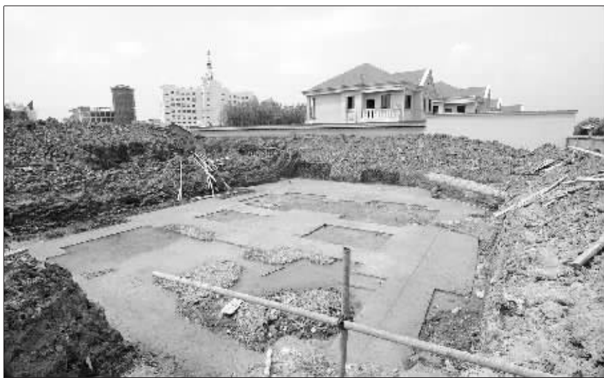
手续未全,垃圾中转站已经动工
