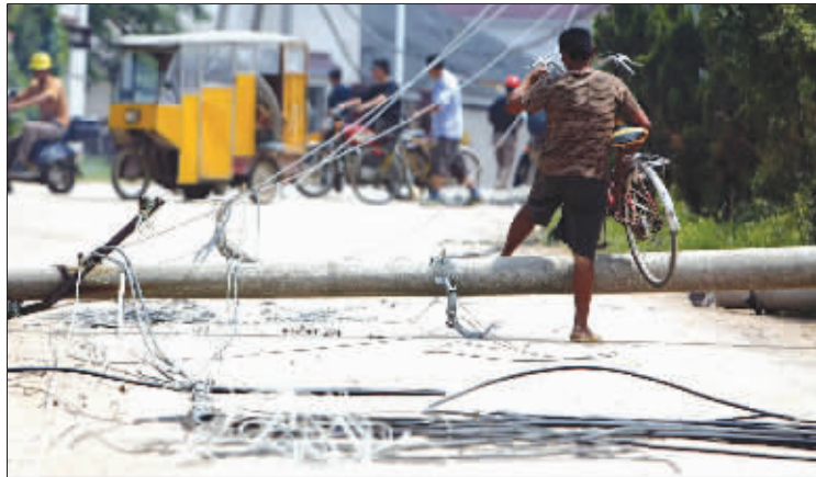
◀ 江宁潘村,电力、电话、有线电视线路全部中断。 快报记者 翁叶俊 摄
