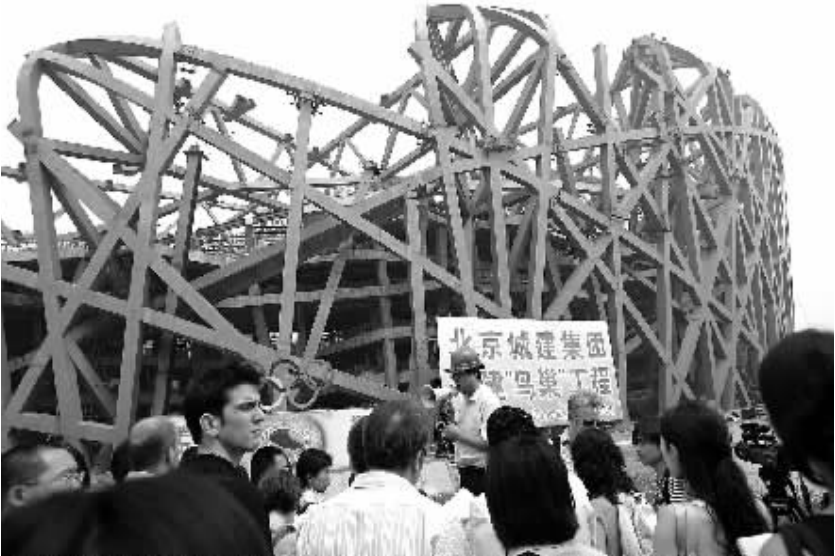
7月14日，各国记者在北京参观国家奥林匹克体育中心工地。
