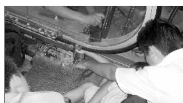
维修人员正在拆开电梯 快报记者 李绍富 摄
