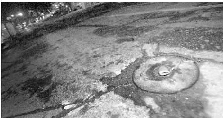
地铁二号线施工围挡后,有的道路还好,有的道路立刻变得不好走了,有了“钉子”。 快报记者 决波 摄
