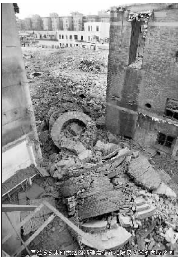
直径5.5米的大烟囱精确爆破在相隔仅7米的两屋之间
