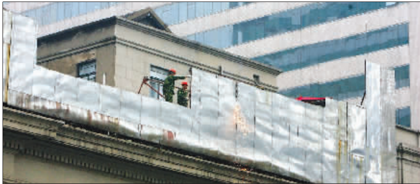
城管正在拆除新街口工商银行楼顶的巨型违章广告牌 快报记者 赵杰 摄
